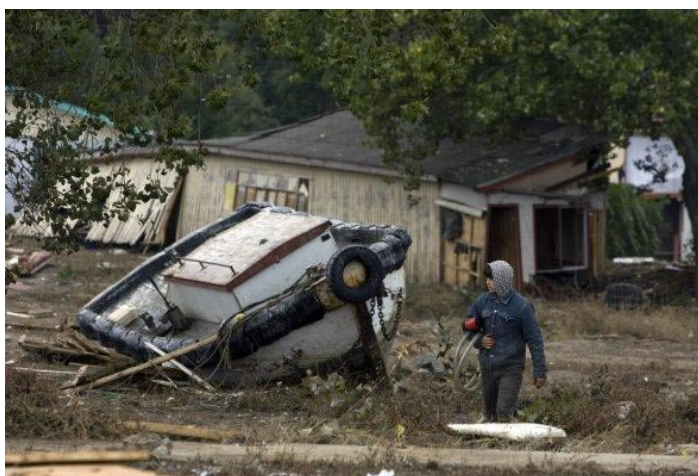
Lancha y casa afectadas por maremoto en DICHATO
