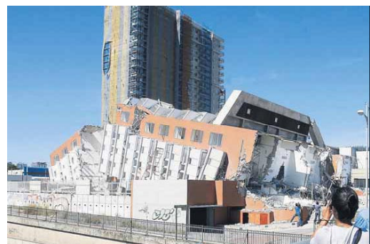
Otro edificio emblemático colapsado en Concepción
